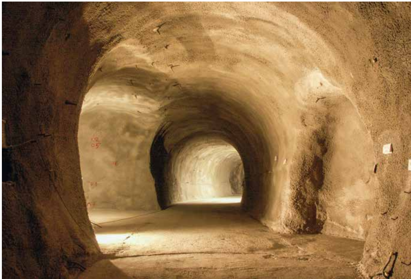
Galerie du laboratoire souterrain du Mont Terri (swisstopo)
