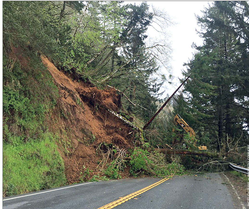
NOURRIS PAR UN LIQUIDE SPÉCIAL, LES MICROORGANISMES créent un ciment naturel qui permet de stabiliser les sols et, par exemple, d'éviter les glissements de terrain.
